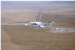
Advanced LIGO: dois interferômetros de laser distantes 3700 Km com braços de 4 Km, fase 1: 2002; fase 2: 09/2015
