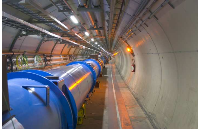
Large Hadron Collider (LHC) - Tunel de 27 Km de circunferência à 100 m de profundidade.
